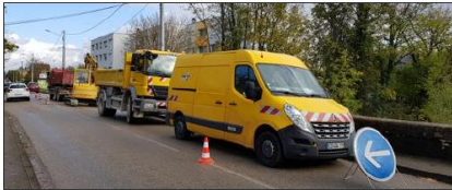
À la sortie d'Ambérieu, avant le passage à niveau de Saint-Denis-en-Bugey et le pont de l'Albarine, un chantier est ouvert pour remplacer une ligne haute tension enterrée. Photo Progrès/Fabienne PYTHON
